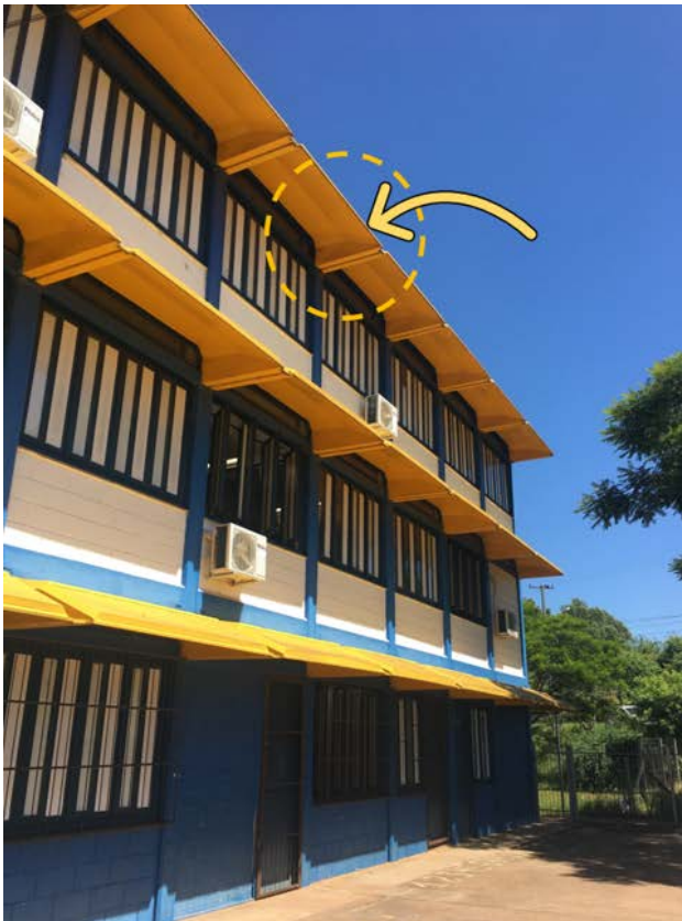
Figura 4: Sistema de brises horizontais nas fachadas. Fonte: Acervo da autora (2018).
