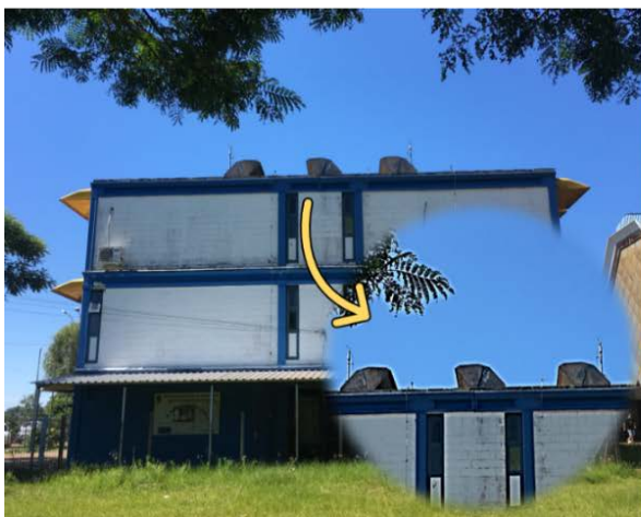
Figura 1: Sheds na cobertura do Bloco Educacional. Figura 2: Aberturas nas laterais do Bloco Educacional. Fonte: Acervo da autora (2018). Fonte: Acervo da autora (2018).
